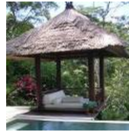
TH100 Negara 2 m x 2 m railing
